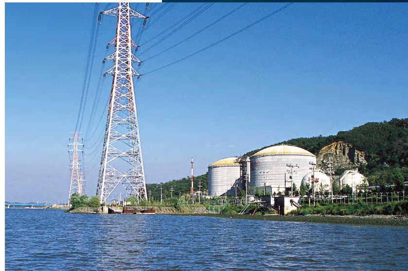
↑ SK가스는 1999년 평택기지를 건설하면서 본격적으로 LPG 플레이어로서 입지를 다지기 시작했습니다. 평택기지 부탄 냉동탱크는 국내에서 최초로 시공되는 공사였습니다.
